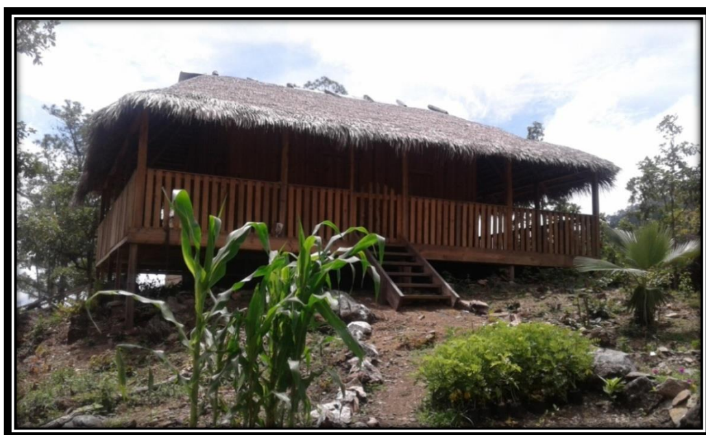
Construcción de Cabinas para uso de Guardianes Ecológicos en la parte alta de la sierra de las Minas Guatemala.
